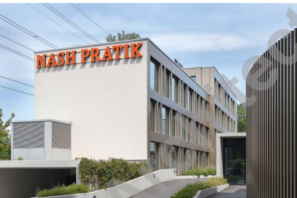
Pour Nash Pratik, les façades sont constituées d'une isolation périphérique recouverte de crépi alternant avec des panneaux composites en aluminium. Le fait que les trois bâtiments du complexe soient de formes et de hauteurs différentes a permis à l'architecte de garder la même teinte pour l'ensemble. Toutes les cellules sanitaires sont des éléments préfabriqués. L'intérieur est revêtu de différents types de marbre, le tout complété par une importante gamme d'accessoires.
